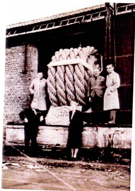
Câble en coco de 30 cm de diamètre, de 60 mètres de long, pesant 30 kg au mètre, destiné à la Marine pour équiper le paquebot « Normandie ».
