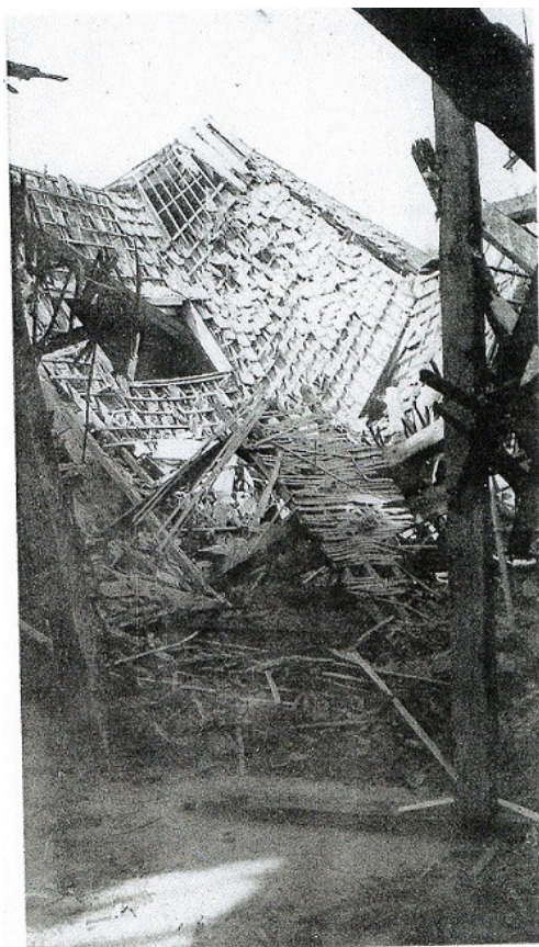
Destruction de l'atelier de mouillage de l'usine Saint Frères
